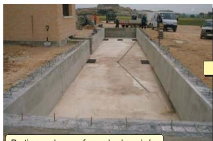
Partimos de un foso de hormigón armado sin coronar la parte superior con placas de anclaje situadas en los puntos de apoyo de la báscula.
