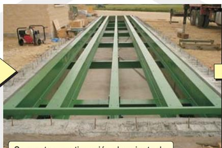
Se monta a continuación el conjunto de vigas y las células de carga que conforman el puente de la báscula.
