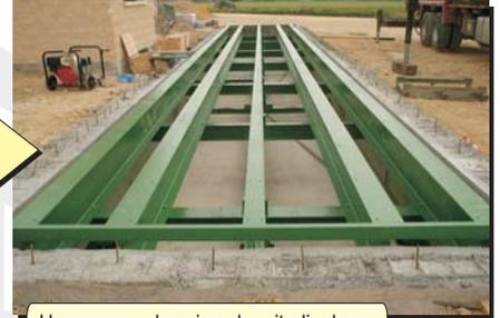
Una vez que las vigas longitudinales y transversales ya están montadas, solo falta montar las chapas superiores, instalar el sistema de pesaje que corresponda y rematar las paredes del foso colocando el perfil angular perimetral.
