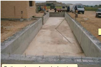
Partimos de un foso de hormigón armado sin coronar la parte superior con caseta para alojar el aparato de romana
