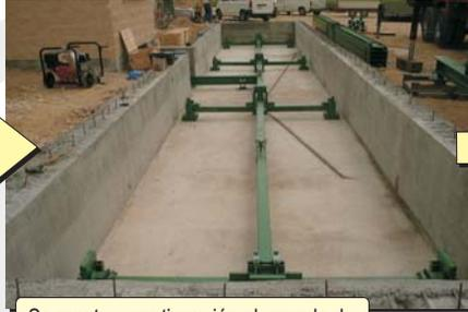
Se monta a continuación el armazón de palancas que sustenta el conjunto de vigas que conforman el puente.
