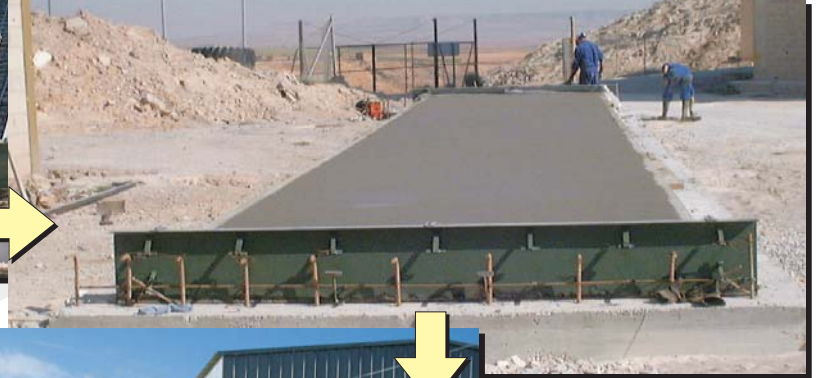
Plataforma después de su hormigonado.
